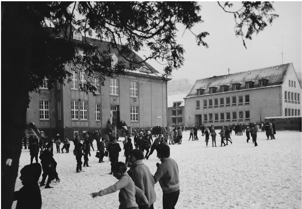
Fassade Altbau und Erweiterungsbau von 1959
